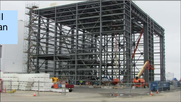
Bldg. 9A Complete December 2019
